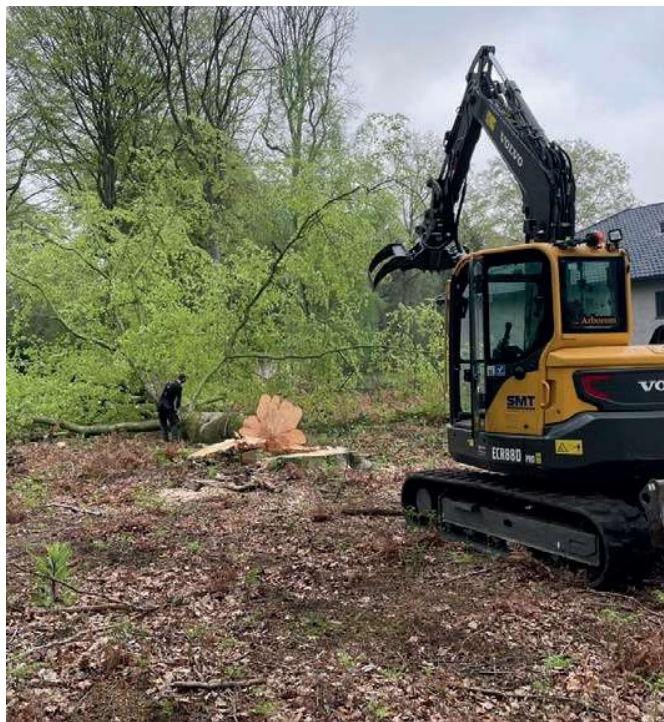
La grue sur chenilles compacte est un atout sur les petits chantiers.
